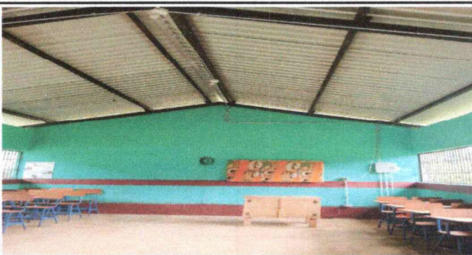
Foto 5: Se observa la reparacion del piso de la escuela.
